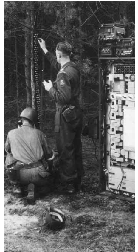
Draaggolfinstallatie CF-1 (vier telefoonkanalen) (Archief Museum Verbindingsdienst)
